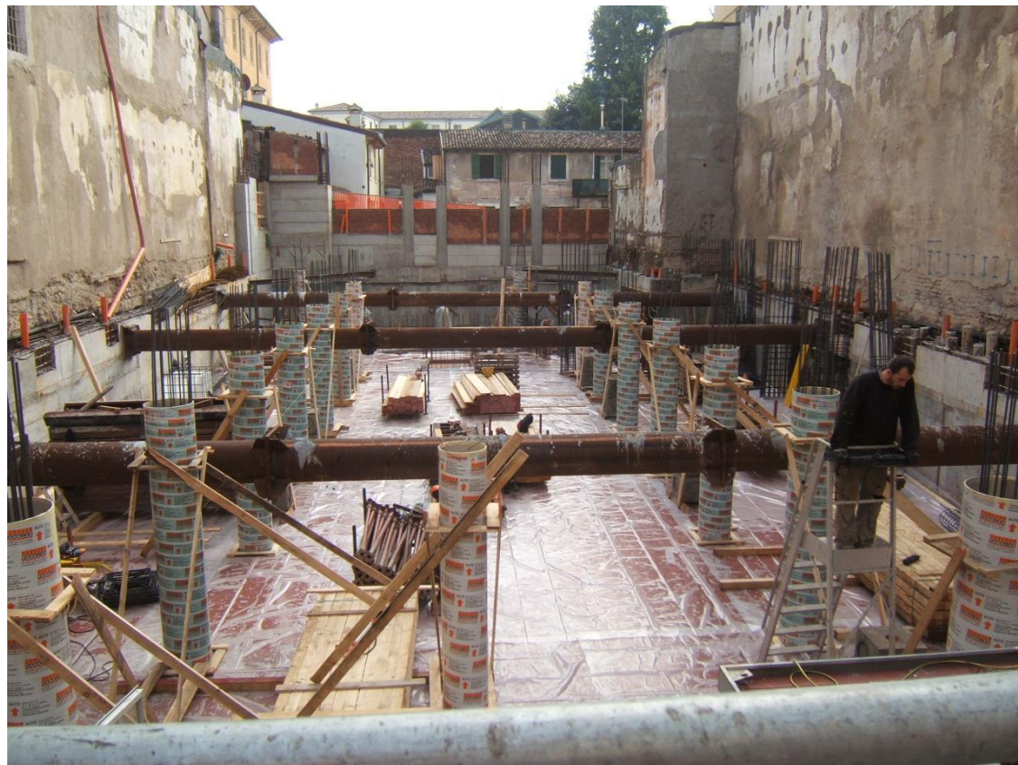
Pilastri I° interrato
