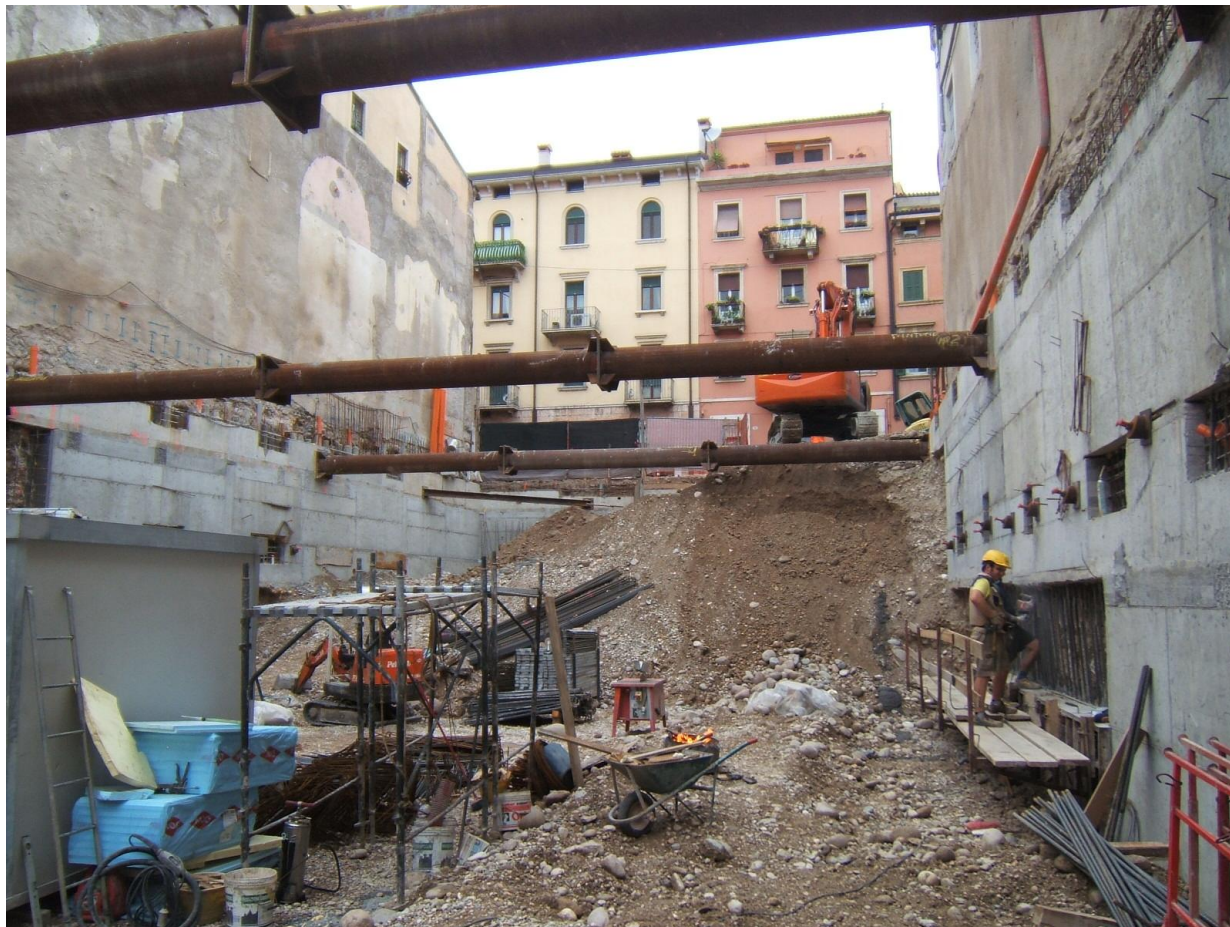
Scavo II° interrato
