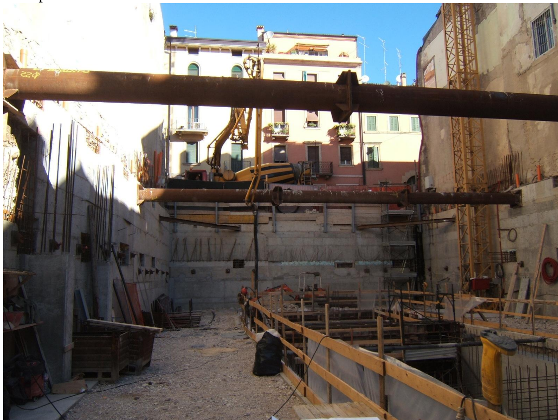
Muri perimetrali II° interrato
